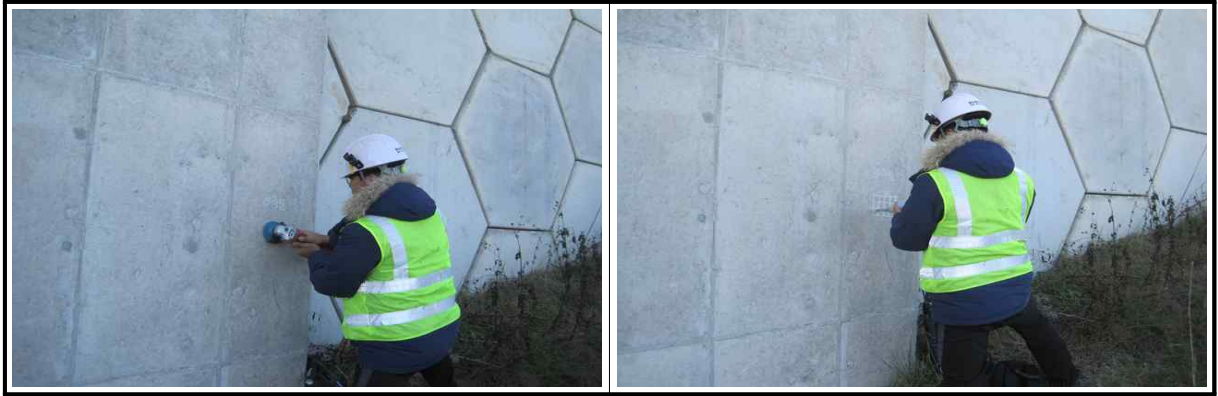
【그림 15.3.6】 슈미트해머를 이용한 반발경도시험 전경
