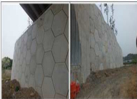
패널식 보강토옹벽 전면 전경
