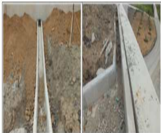
옹벽 전면 배수로 전경
